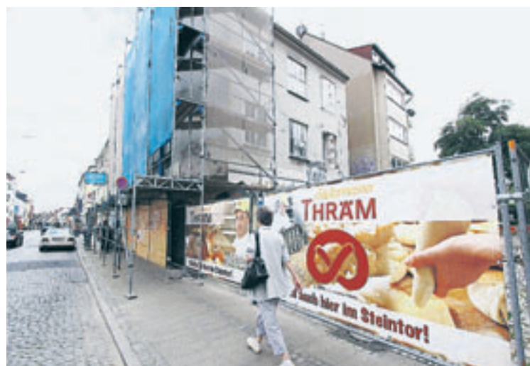
Früher war an dieser Ecke der Friseursalon „Hannelore“. Seit einiger Zeit wird das Haus saniert, ein Nebengebäude ist miteinbezogen. Die umfangreichen Bauarbeiten sind bald zu Ende. Auf der Absperrung kündigt ein Plakat schon von der Neueröffnung: Bäcker Thram wird ab diesem Jahr mit einer Filiale im Steintor vertreten sein. Siehe Bericht auf Seite 2. FOTO: W. GERBRACHT
